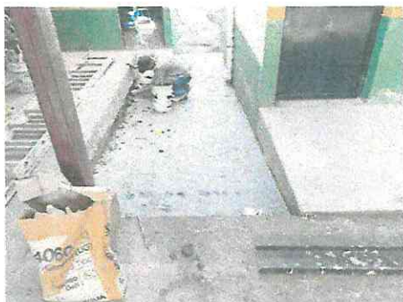
Foto 3: Reparación de Banqueta
