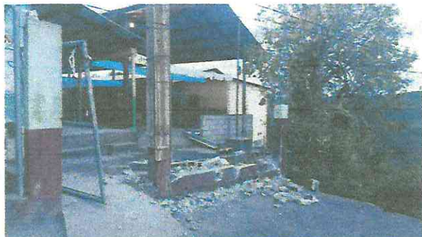
Foto 1: Ampliación de portón principal
