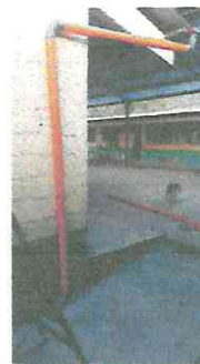
Foto 6: Canales y bajadas de agua pluvial en patio
