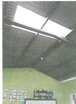
Foto 2: Sustitución de lamina
