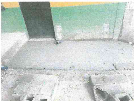
Foto 7: Reparación puertas de metal
