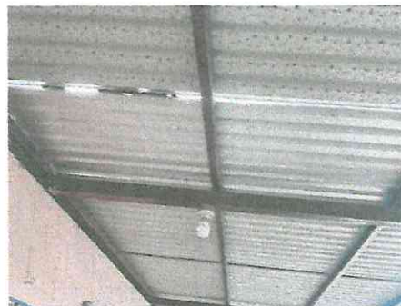
Foto 4: Reparación de Sistema Eléctrico
