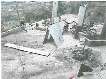
Foto 9: Reparación banqueta de concreto
