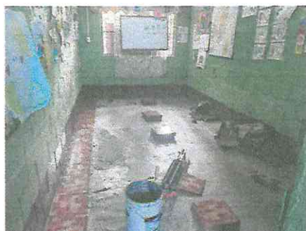
Foto 5: Reparación de Piso
