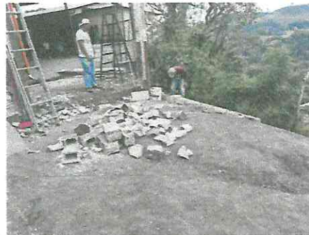
Foto 10: Ampliación rampa de portón
